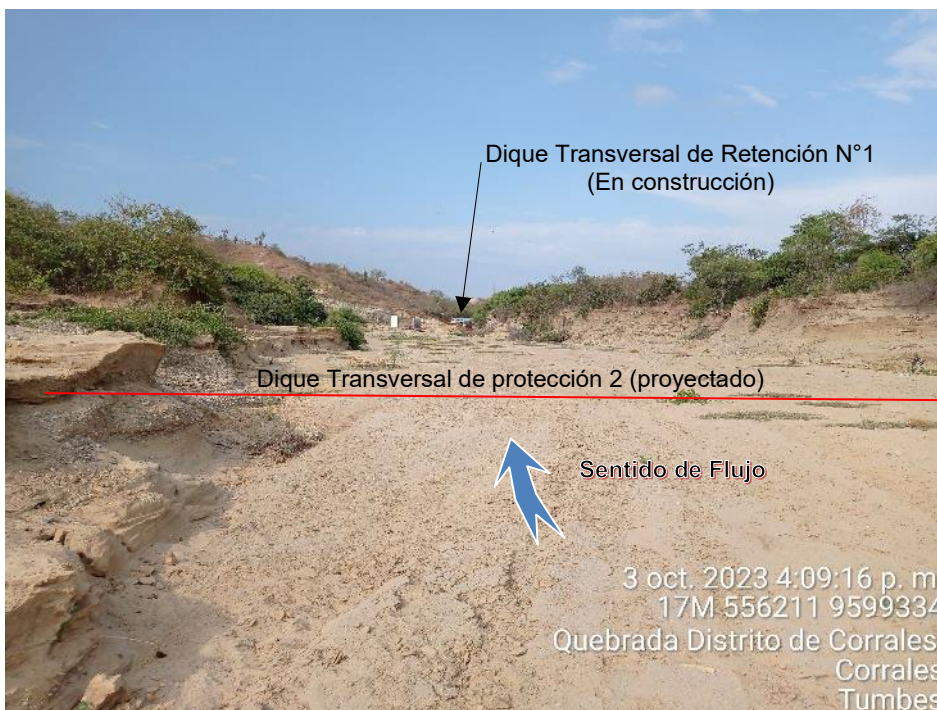
Figura 2. Dique transversal de protección N°2 proyectado.
