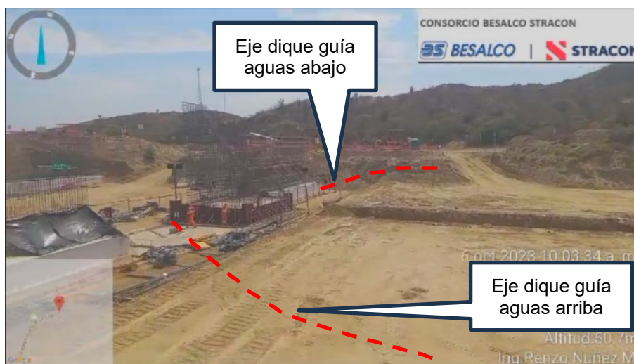
Figura 17. Ejes dique guía con respecto al dique transversal 02.
