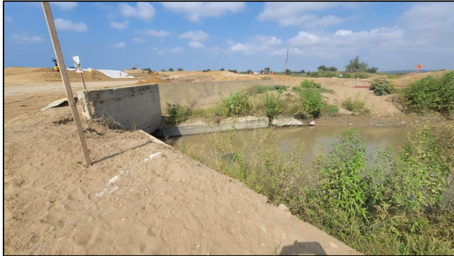
Figura 1. Alero de salida de Canal La Variante
