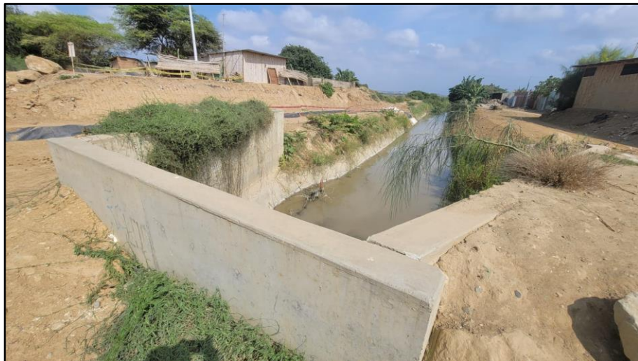
Figura 2. Alero de ingreso de Canal Margen izquierda
