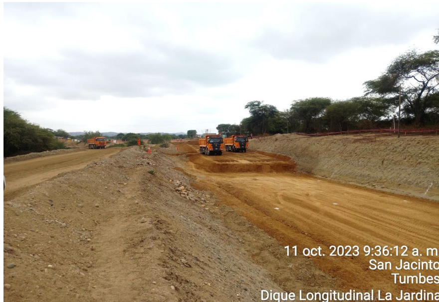
Figura 13. Trabajos de conformación de dique longitudinal MI.
